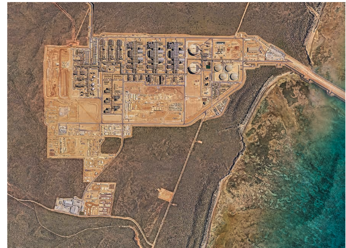
8.13 > In dieser Flüssiggasanlage auf Barrow Island, Australien, wird Kohlendioxid bei der Erdgasaufbereitung abgeschieden und in einiger Entfernung in zwei Kilometer Tiefe unterirdisch verpresst.
