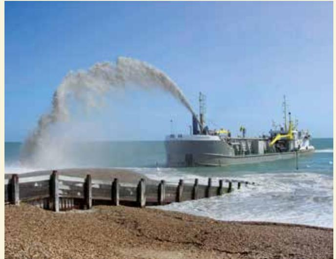
**2.9 > Beim sogenannten Regenbogenverfahren wird das Sand-Wasser-Gemisch vom Schiff aus auf den Strand gepumpt.**
