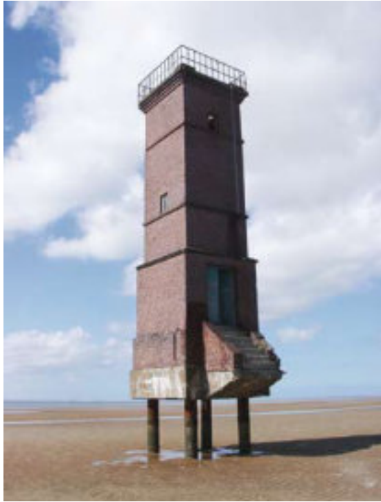
3.7 > Der alte Leuchtturm der ostfriesischen Insel Memmert stand einst in den Dünen und wurde durch Erosion im Laufe von Jahrzehnten freigespült.
