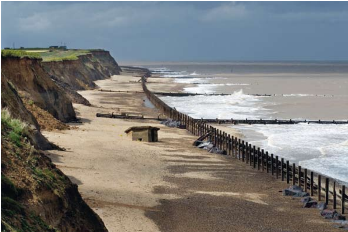
3.2 > Vor der kleinen englischen Ortschaft Happisburgh frisst sich die Nordsee bei jedem Sturm weiter in das Land. Die alten Küstenschutzanlagen können dagegen kaum etwas ausrichten. Ein Bunker aus dem Zweiten Weltkrieg ist bereits von den Klippen gestürzt. An anderer Stelle gingen Häuser verloren.
